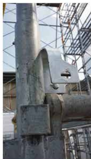
③ 横架材(ブラケット)に金具取付
