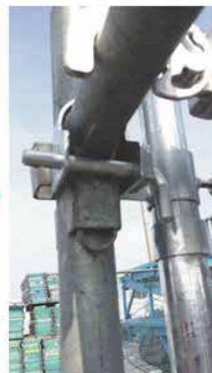
④ 金具の固定
